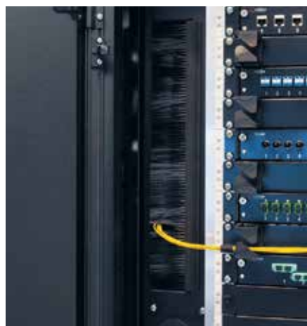
Щеточное уплотнение кабельного ввода
